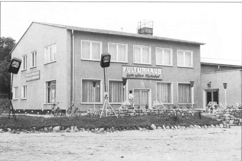
Oben: Das Bahnhofsgebäude Gera-Pforten von der Straßenseite. Durch das Gefälle der Straße liegen die Gleise in der Höhe des ersten Ohergeschosses. 1983
