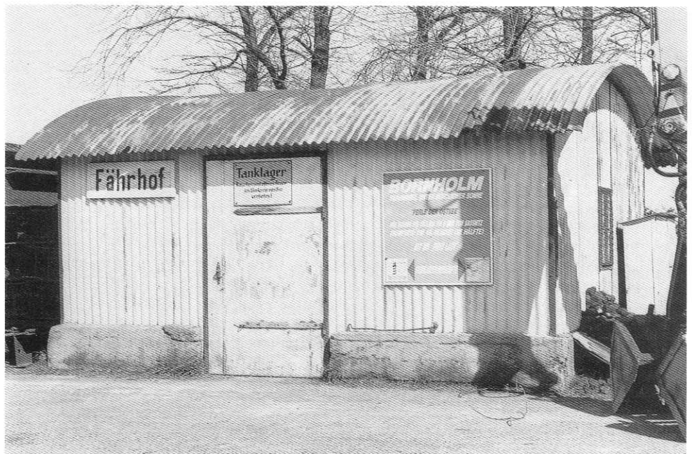
Rechts: Wellblechbude im Bahnhof Fährhof der Rügensch Kleinbahn, 14. 5. 1991, Foto: Wolfram Bäumer
