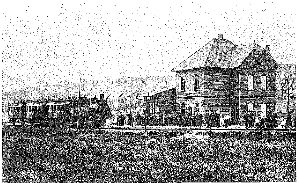
Gruf aus Salchendorf. Der neue Bahnhof.
