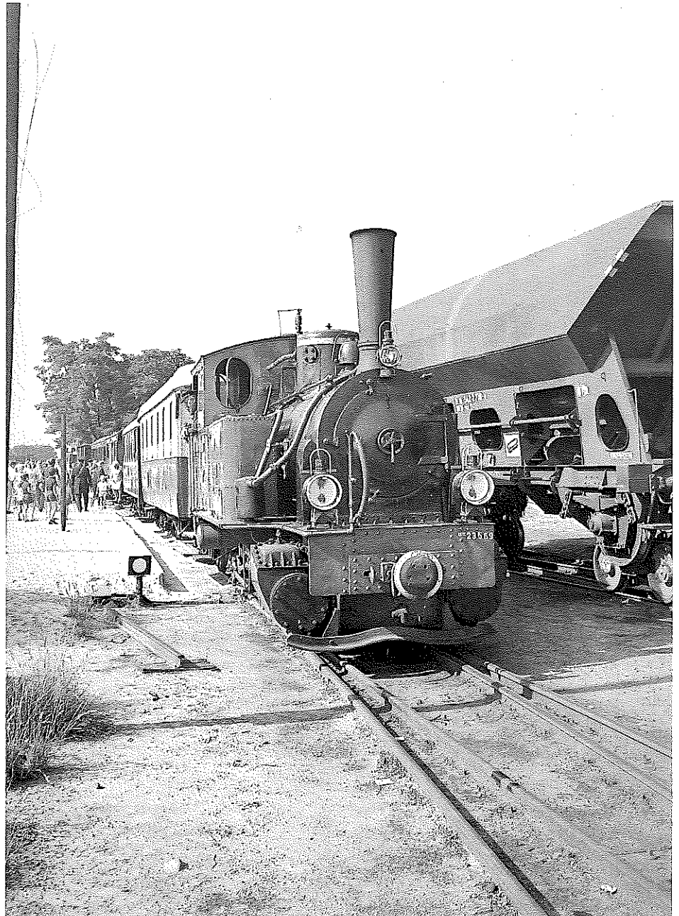
Rechts: Vor 25 Jahren weitete die Museums-Eisenbahn den planmäßigen Zugbetrieb bis Asendorf aus, wo damals noch parallel zum Museums-Eisenbahnverkehr lebhafter Güterverkehr mit aufgeböckelten Regelspurgüterwagen herrschte. 1969, Foto: Michael Breitschwert
