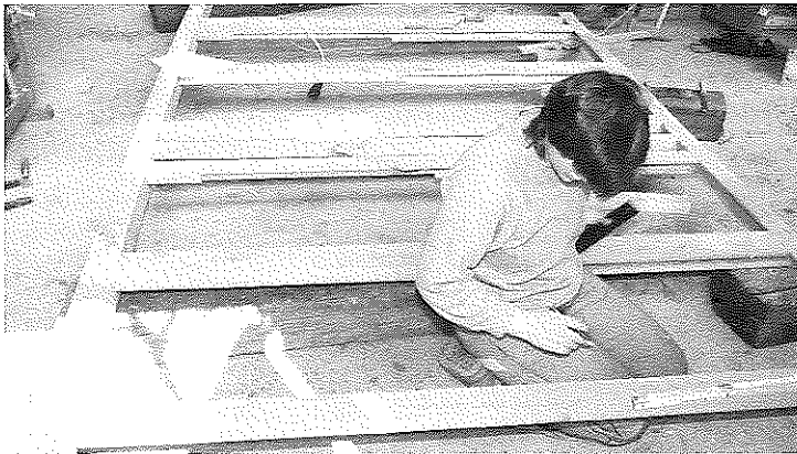
Die Wagenwände bestehen aus mehreren, in der Werkstatt vorgefertigten Fachwerkteilen, die vor Ort zusammengesetzt werden. Foto: BZE Euskirchen, Prinz
