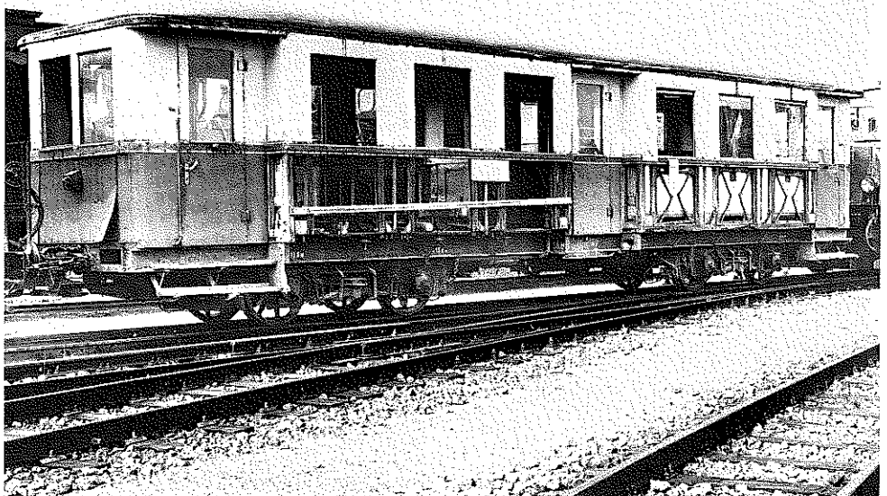
Personenwagen DEV Nr. 21 bei der Schadensaufnahme. Vorne ist der Grundbalken bereits zur Erneuerung ausgebaut. 1. August 1988.
