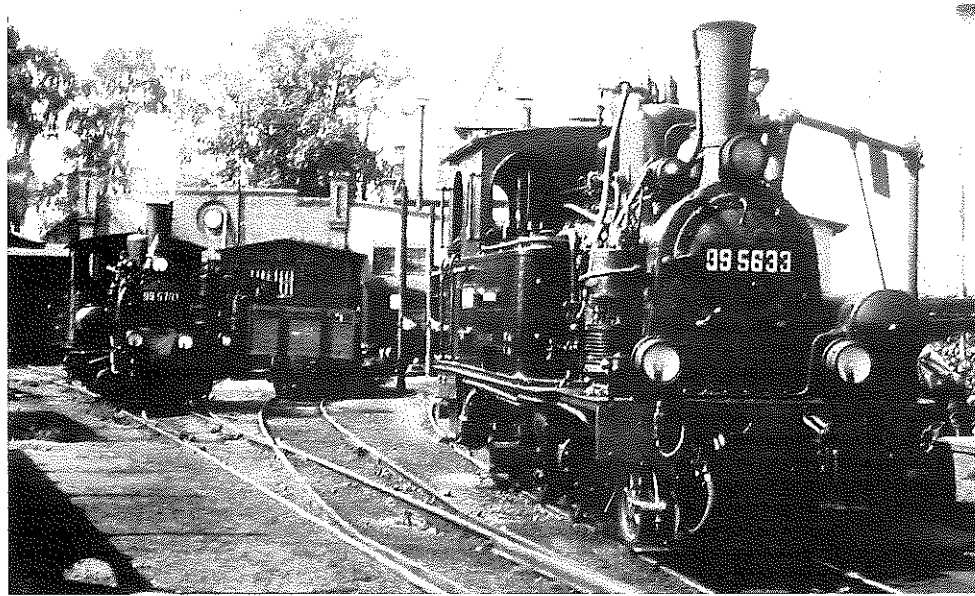
Auf dem Umlauf an der Heizerseite war bei der Reichsbahn der Hauptluftbehälter angeordnet. Im Mai 1966 nimmt die 99 5633 im Bw Cottbus Ast Straupitz Wasser, während hinten die LIEBEROSE rangiert. Foto: Dipl.-Ing. Klaus Kleper
