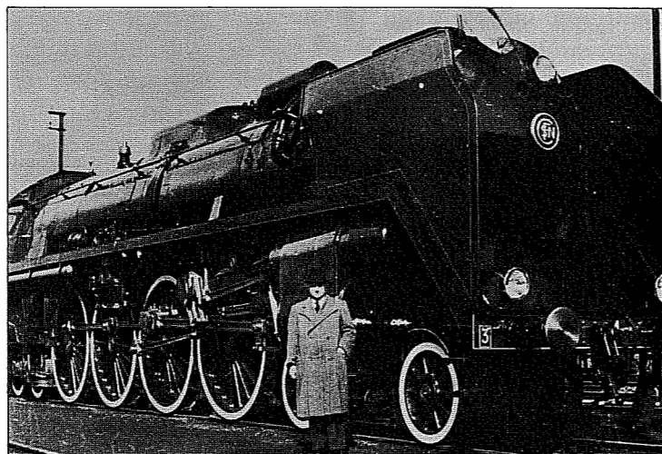
Schnell, stark (110 km/h — 3 000 Pse- und mit typischem „Chapelon-Gesicht“ waren die Lokomotiven der Baureihe 141 P sowohl vor raschen Expreszügen als auch vor schweren Güterzügen immer wieder zu sehen (hier: 141 P 9) (Foto: La Vie Du Rail)
