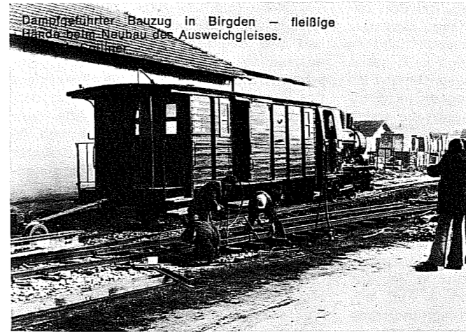
Bahnhof Birgden: die neue Weiche liegt, und nun geht's an die Schließung der Längs-Hauptgleise! Foto: U. Spillner
