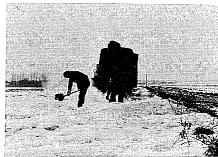
Winterbetrieb bei der Selfkantbahn: Das Zugpersonal eines Bauzuges schaufelt eine Schneeverwehung bei Gelindchen frei. Foto: H. Wall
