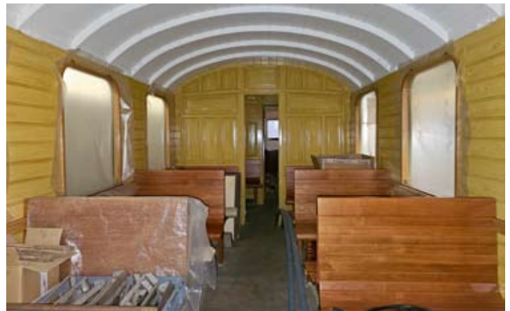
Anfang Oktober gelang ein Blick in den Innenraum des „neuen“ Buffetwagens, hier geht's langsam, aber stetig mit den Arbeiten voran. 02.10.23, vier Fotos: RM
