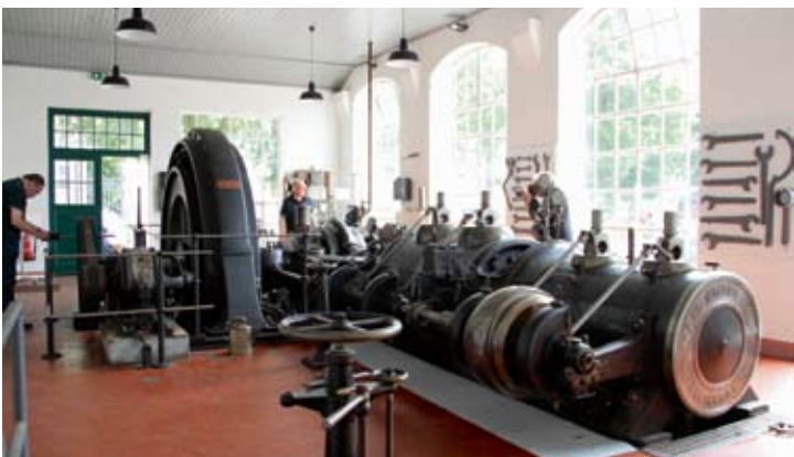
Im Krafthaus der Senffabrik wurde die stationäre Dampfmaschine der Firma K.H. Möller GmbH aus Brackwede, Baujahr 1911, im Betrieb gezeigt, die 1928 übernommen wurde und zur Stromerzeugung diente.
