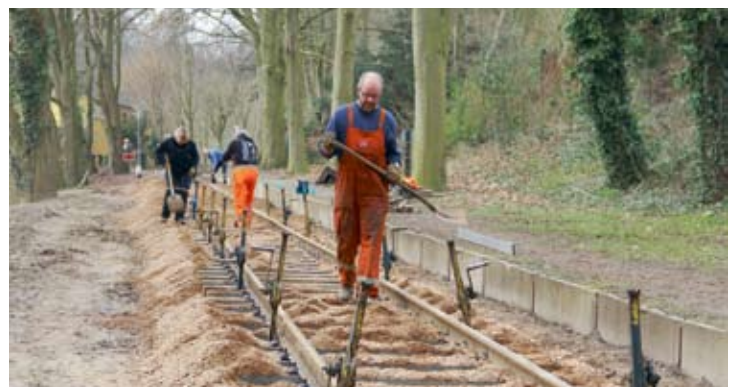
Danach wurde das Gleis „auf Höhe gebracht“. Jens Böcker, dahinter Alexandra Hillebrecht und Bernhard Öhler sowie Klaus Eggemann (ganz hinten) stopfen mit Schaufeln die Schwellen vor. 18.03.23, alle Fotos: RM
