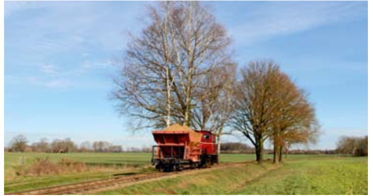
Im Heiligenberger Grund lagerte der Kies für die Gleisbaustelle, wurde mit dem Radlader in den „Schotter“wagen geladen und dann zur Baustelle gebracht. Hier Wagen 163 und V3 in der Heiligenberg Kurve. 17.03.23
