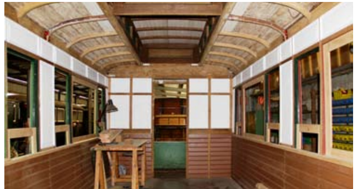
Ein Blick in den Innenraum des Wagen 16. Mittlerweile ist die Holzverkleidung in Bearbeitung. 06.02.23
