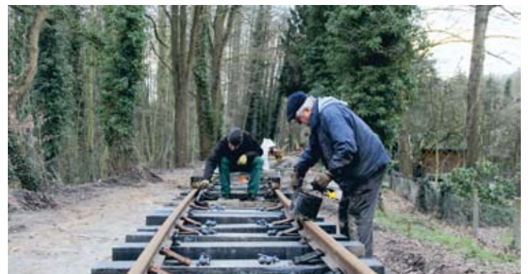
„Schwarzmaler“ Joachim Gorr beim Anstreichen der Unterlagsplatten und Schrauben mit Bitumenfarbe, während Uwe Hempfen-Hermeier im Hintergrund einen fahrbaren Sitzplatz hatte. 16.03.23, vier Fotos: RM
