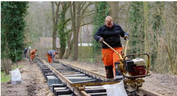
In der Gleisbauwoche wurden dann die neuen Schwellen unter erschwerten Bedingungen ausgelegt und anschließend das Gleis montiert. Hier Franziska Siedenberg beim Anziehen der Schrauben mit der Eindrehmaschine. 16.03.23
