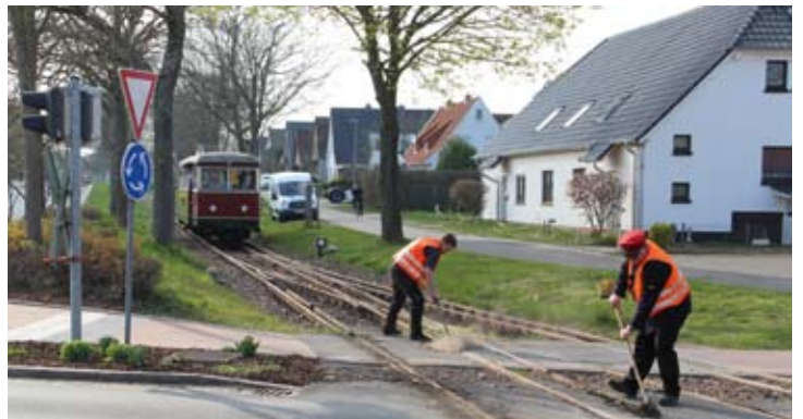
Nach Rückankunft des T 44 aus Heiligenberg nutzten Aufsicht und Zugleiter Dirk Lonscher und Leon Mohring die Sperrung des BÜ für den Straßenverkehr zur Reinigung der Spurrillen. 09.04.23, alle Fotos: RM
