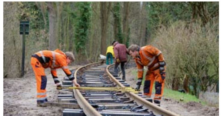
In der Gleisbauwoche wurde die DEV-Rotte wieder einmal von Azubis der Mindener Kreisbahn unterstützt. Lionel Olschewski und Simon Genz zeichneten die korrekte Lage der Schwellen in der Kurve an. 16.03.23
