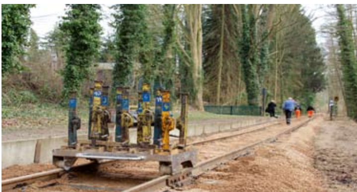
Zur vormittäglichen Kaffeepause am Sonnabend sah das Gleis am Bahnsteig in Wiehe schon ganz passabel aus. Die Winden standen auf dem Rollbrett bereit, um damit das Gleis später für die Stopfmaschine zu heben. 18.03.23
