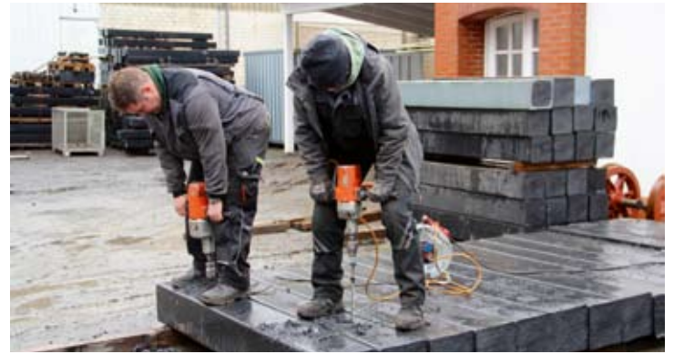
Beim Sonabend-Meeting im Februar wurden die Schwellen für die März-Baustelle gebohrt. Lasse Christensen und Insa Drechsler-Konukiewitz legten sich bei feuchtem Wetter dafür ordentlich ins Zeug. 18.02.23, Foto: RM
