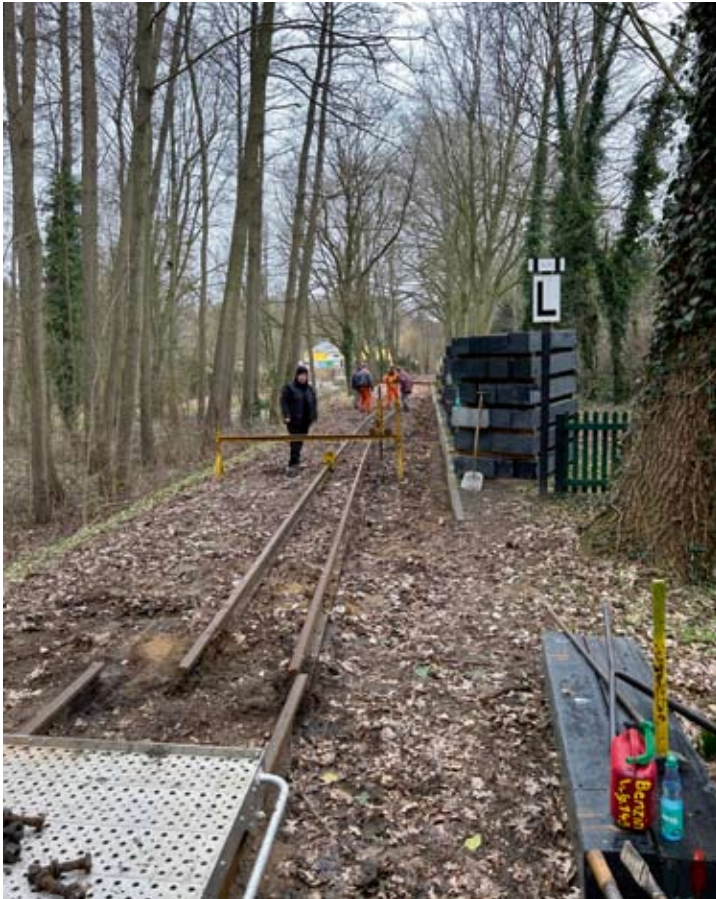
Anfang März begann der Rückbau des alten Gleises vom BÜ Homfelder Straße bis zum Hp Wiehe Kurpark. Die Schienen waren am Hp Wiehe bereits gelöst und lagen bereit zur Zwischenlagerung. 04.03.23, Foto: Nils Böcker
