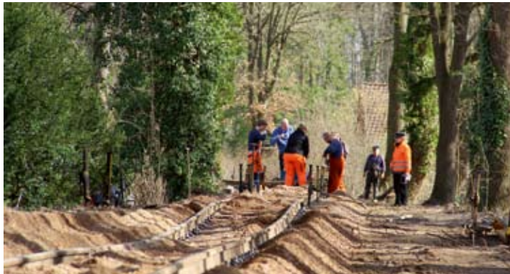
Mit dem Tele wirkte das neu verlegte Gleis viel „welliger“, als es tatsächlich war. Für das Ausbringen des Kieses war es bereits befahrbar und viele Hände halfen bei der Fertigstellung. 17.03.23
