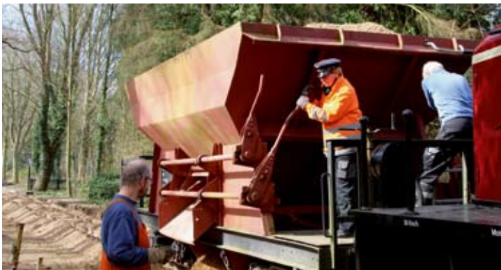
Mit fachkundiger Begleitung von Gleisbau-Ingenieur Jens Böcker verteilten Frauke Lehmann und Klaus Eggemann den Kies am Gleis, nicht zu viel und nicht zu wenig ... 17.03.23
