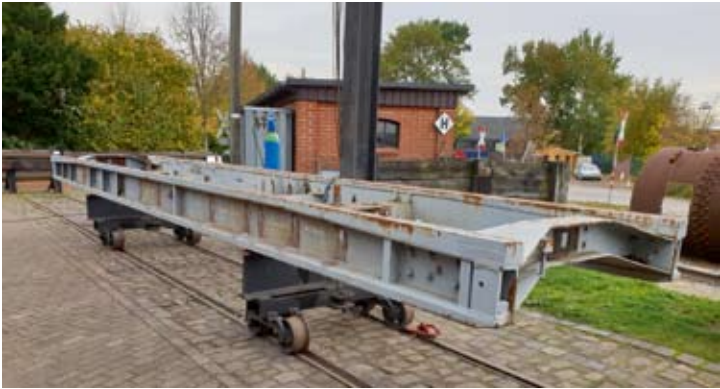
Der auf Robelachsen aufgebockte und von Anbauteilen befreite Rahmen des Rollwagens Nr. 178 neben der Werkstatt in Bruchhausen-Vilsen. 28.10.2022, Foto: Uwe Franz
