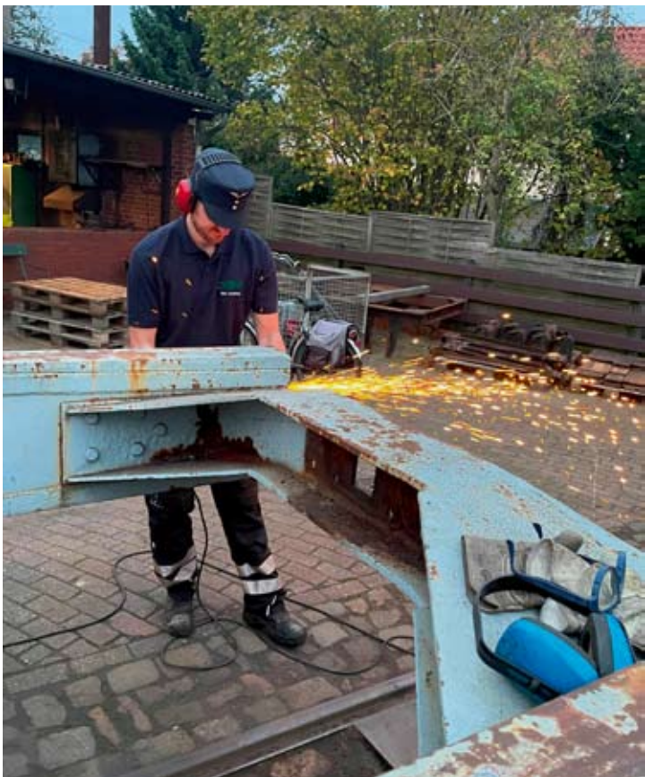
Eike Amelung bei ersten Schleifarbeiten am Rahmen von Rollwagen Nr. 178. Bruchhausen-Vilsen, 22. Oktober 2022, Foto: Lars Böcker
