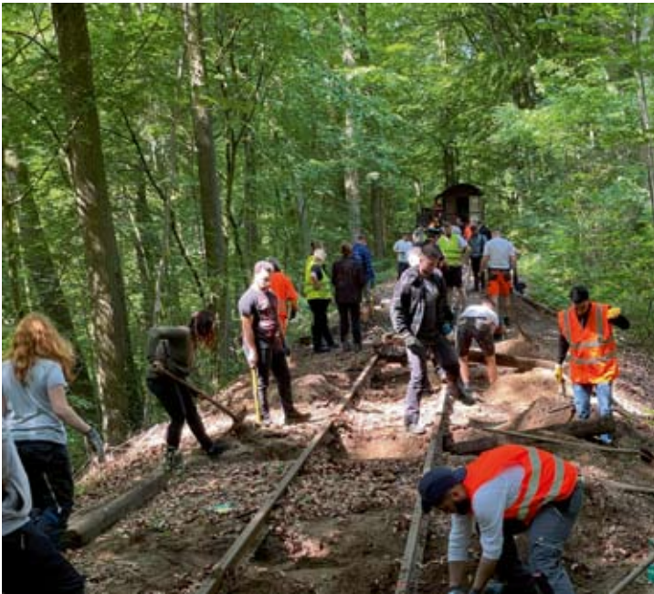
Carsten-W. Müller stellte zwei Foto der Studierenden-Rotte vom 4. Juni 2022 zur Verfügung: Die Rotte beim Schwellenwechseln im Vilser Holz ...
