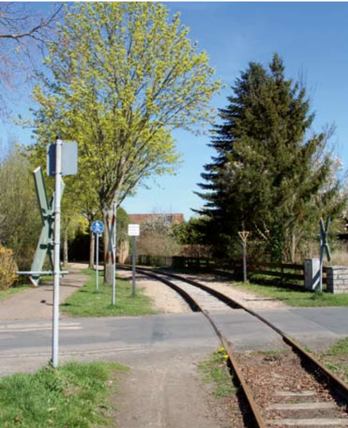
Die frisch fertiggestellte Kurve an der Bollenstraße in der Frühlingsblüte der umliegenden Gärten.
