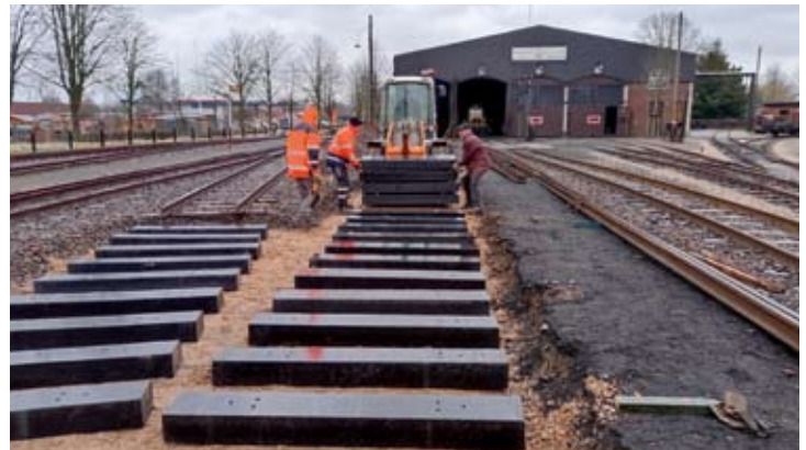
18. Februar: Nachdem die neuen Kunststoffschwellen abgelängt und gebohrt worden waren, wurden sie paketweise von Ralf per Radlader ausgefahren und konnten verlegt werden.
