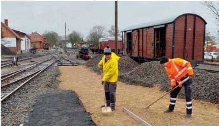
Je genauer Robert und Klaus das neue Kies-Planum ebnen, desto gleichmäßiger liegen die Schwellen und desto leichter ist die Gleismontage. 17. Februar, Foto: Ralf Hormann
