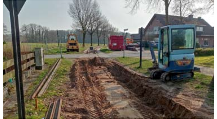
Am 21. März war die Trasse fertig ausgekoffert und planiert, hier der in einer leichten Kurve liegende Abschnitt vor dem BÜ Bollenstraße. Foto: Ralf Hormann
