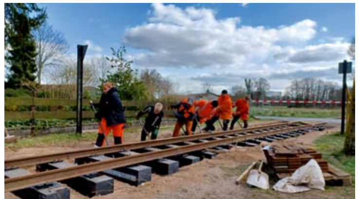
Damit das Gleis wieder zu einer Kurve wird, wurde erst einmal nur eine Schiene festgeschraubt und es dann per Brechstangen in Position gebracht. 2. April 2022, Foto: Mechthild Schröder
