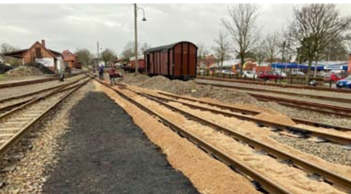
Am 24. Februar war die neue Kiesbettung durch den Schotterwagen eingebracht und wurde von Joachim und Konrad eingeebnet. Foto: Jens Böcker
