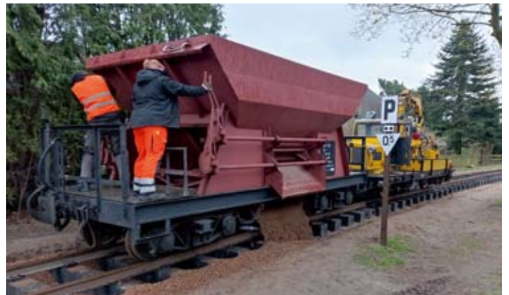
Dienstag, 5. April: Nils und Franz bedienten die Schütten des Schotterwagens 152. Schön anzusehen ist, wie der Kies ins Gleis rutscht.
