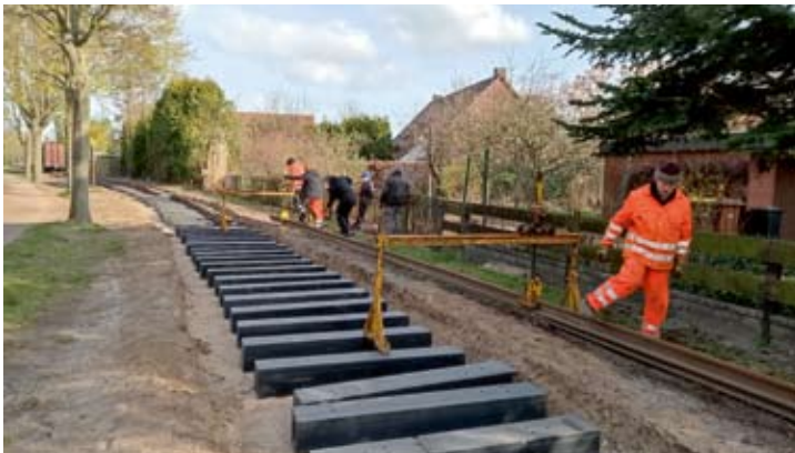
Ab dem 1. April wurde das neue Gleis hergestellt: Schon am 2. April lagen die neuen Kunststoffschwellen, und mit Übersetzgeräten wurden die Schienen wieder verlegt.
