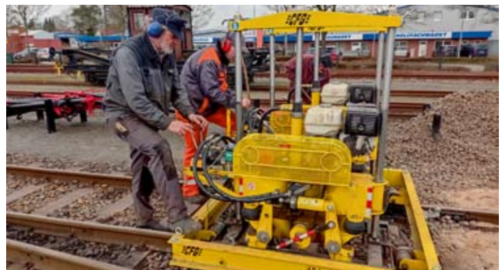
Nach dem Nivellieren des Gleises konnten sich Robert und Jens mit der Stopfmaschine austoben und das Gleis stopfen. Bruchhausen-Vilsen, 24. Februar 2022.
