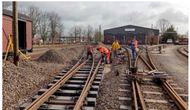
Am 22. Februar herrschte emsiges Treiben in der Weiche 15: Für jede Schienenplatte musste mühsam und zeitaufwändig gesondert gekörnt und gebohrt werden.
