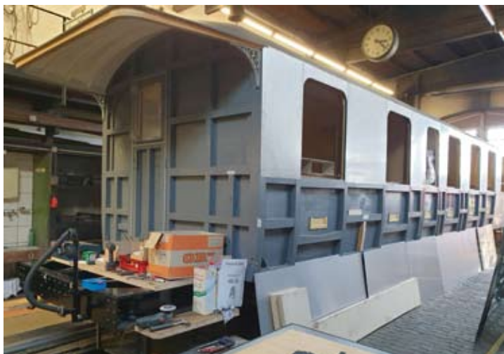
Die neue, passgenau vorgefertigte Wandverblechung wurde im März an Wagen 7 angebracht. Mittlerweile ist die Verblechung fast komplett montiert.
