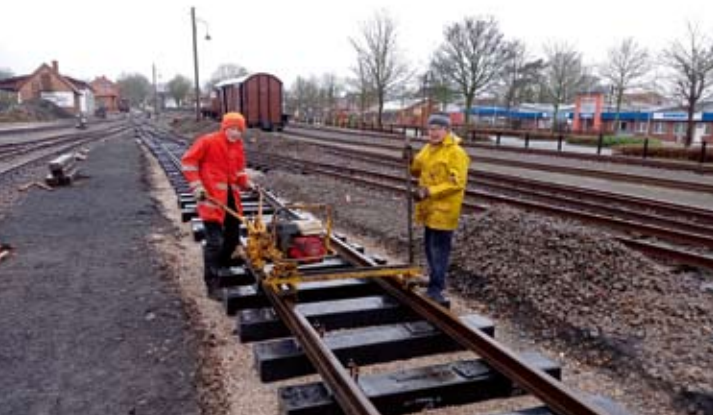
Am 20. Februar waren die Schienen wieder verlegt und konnten durch Hauke und Ralf II mittels Schraubenmaschine bei mäßigem Wetter verschraubt werden.
