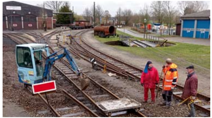
Mit Radlader und Minibagger beseitigte Ralf am 16. Februar die alte Schotterbettung. Birgit, Kalle und Konrad hatten Pause und schauten zu.
