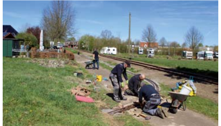
Auch am Kindermannweg neben der Ausfahrt aus dem Bahnhof Bruchhausen-Vilsen gab es eine Gleisbaustelle, allerdings für die Erweiterung der Echtdampfbahn beim Gartenbahn-Café.
