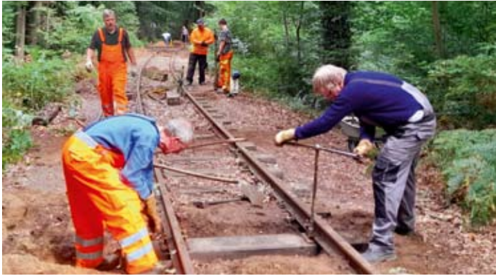
Die Gleisbaurotte im Einsatz im Vilser Holz: Bernhard Öhler und Kalle Waack schrauben eine ausgewechselte Schwelle fest. 25. September 2021. Foto: Hartwig Harms
