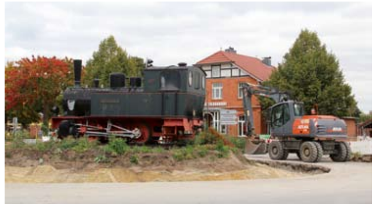
Der Kreisel am Bahnhof rund um Denkmallokal BRUCHHAUSEN war im Oktober eine große Baustelle. Bruchhausen-Vilsen, 7. Oktober 2021. Foto: RM
