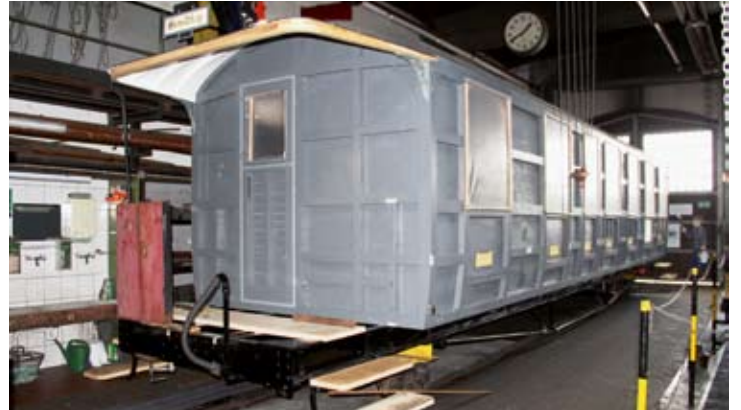
Rahmen und Wagenkasten von Wagen 7 sind jetzt wieder vereint. Aktuell werden die Einstiegsbühnen in der Werkstatt instandgesetzt. Bruchhausen-Vilsen, 2. September 2021. Foto: RM
