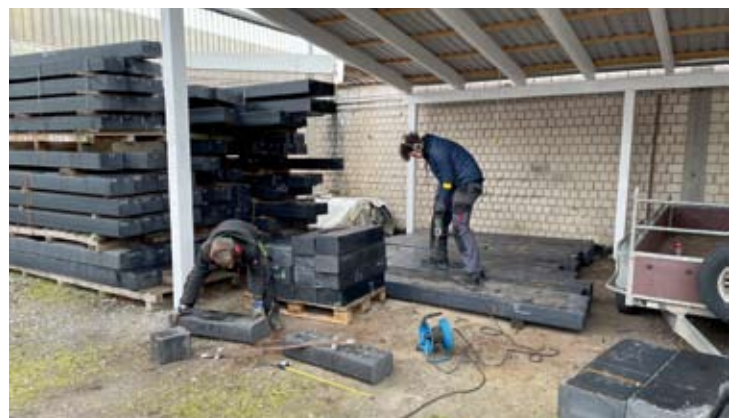
Für die Sanierung des Gleises im Heiligenberger Grund bohren Nils Böcker und Alexander Hansing die neuen Kunststoffschwellen vor. Bruchhausen-Vilsen, März 2021. Acht Fotos: Lars Böcker
