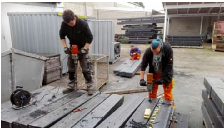
Für die Gleiserneuerung am Bahnhof Bruchhausen-Vilsen mussten die Kunststoffschwellen gebohrt werden, wie hier von Nils Böcker (links) und Max Hunold. 26. September 2020, Foto: Robert Angerhausen
