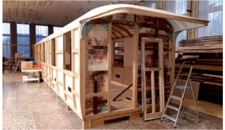
In der Tischlerei in Zwönitz stehen die Holzarbeiten am Aufbau von Wagen 7 am 21. Oktober 2020 kurz vor dem Abschluss, während das Fahrwerk in Bruchhausen-Vilsen restauriert wird. Foto: Veikko Hübner
