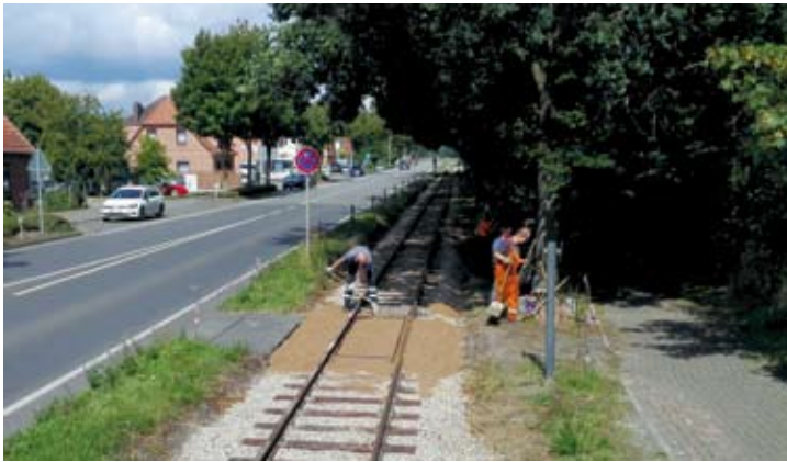
Restarbeiten am erneuerten Gleisabschnitt kurz vor dem Bahnhof Asendorf: Die Stahlkästen für die Pflasterung des Überwegs werden gesetzt. 29. August 2020, Foto: Robert Angerhausen
