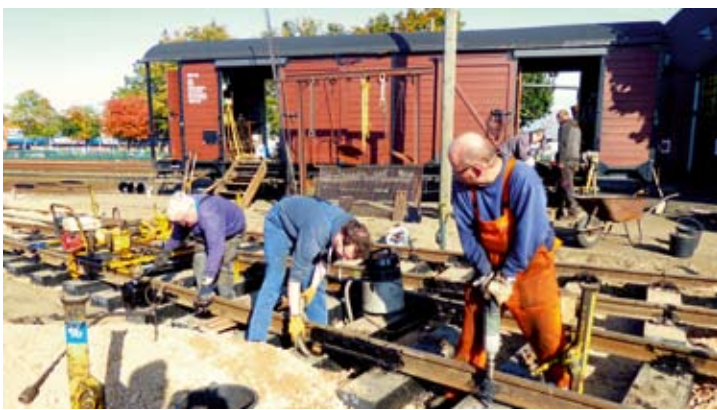
Joachim Gorr, Richard Wilkening und Jens Böcker (v.l.n.r.) beim Montieren der Weiche 12 und Einstreichen der Schienenlaschen mit Korrosionsschutz. 16. Oktober 2020, Foto: Robert Angerhausen
