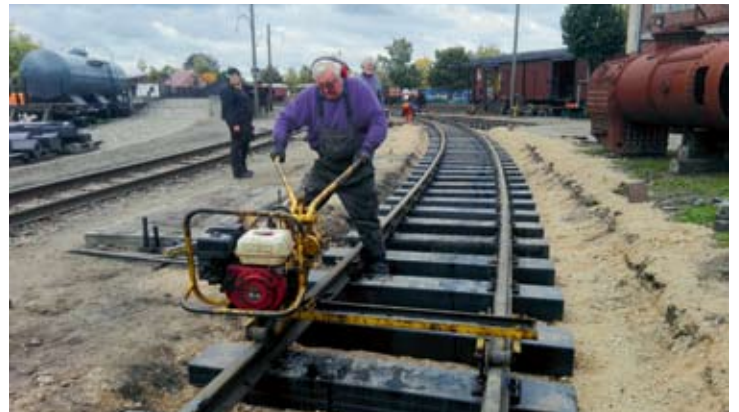
Bei laufendem Betrieb (die Saison wurde ja um drei Wochen verlängert) wurde weitergearbeitet: Am 14. Oktober schraubte Joachim Gorr die Schienen mit dem Robel fest. Foto: Robert Angerhausen
