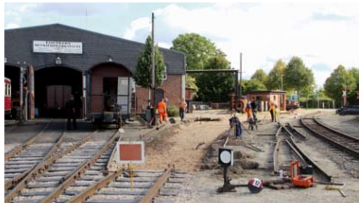
Weiche 12 und das Tankstellengleis waren diesen Herbst an der Reihe: Der Gleisrost ist schon entfernt und der Untergrund planiert. Bruchhausen-Vilsen, 10. Oktober 2020. Foto: RM
