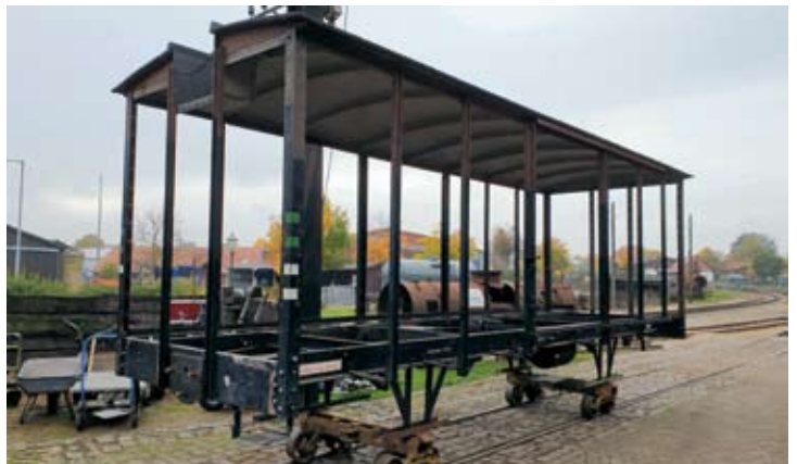
Güterwagen Nr. 129 ist ausgeachst und bis auf das Gerippe entkleidet. Er kann nun gesandstrahlt werden. Bruchhausen-Vilsen, 23. Oktober 2020. Foto: Uwe Franz
