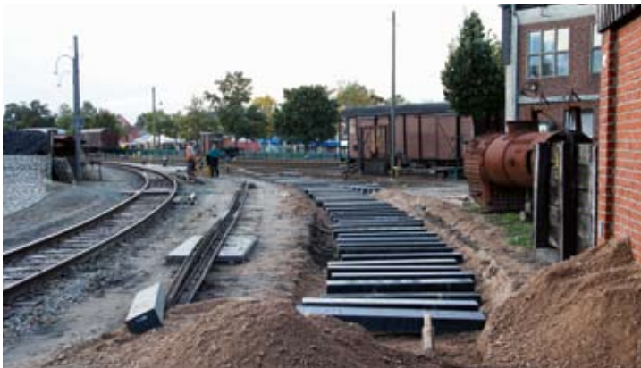
Noch am selben Tag waren die neuen Schwellen ausgelegt, und anschließend konnten die Schienen wieder aufgelegt werden. Bruchhausen-Vilsen, 10. Oktober 2020. Foto: RM
