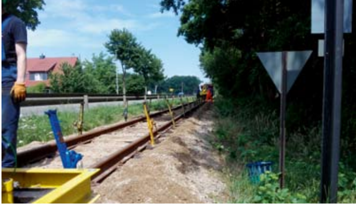
Bevor die Stopfmaschine stopfen kann, muss der Oberbau mittels Winden nochmal ausgerichtet und nivelliert werden. Asendorf, 27. Juni 2020. Foto: RA
