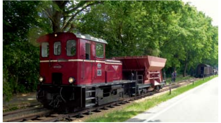
Zwei Tage später war das Gleis schon montiert, und die ersten Füllungen mit Kies konnten mittels V 3 und Schotterwagen Nr. 163 eingebracht werden. Foto: RA
