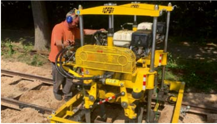
Ralf Hormann bändigt derweil die Stopfmaschine, damit die Gleise auch in Zukunft wieder stabil liegen. Asendorf, 27. Juni 2020. Foto: Jens Böcker
