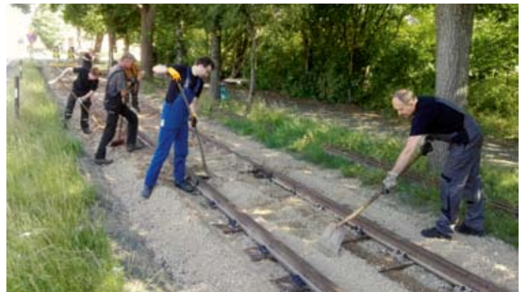
Ende Juni wurden dann an drei Tagen 150 t Kies ausgefahren und 500 m Gleis gefüllt und gestopft. Mit vielen Helfern geht das schnell und macht Spaß! 26. Juni 2020, Foto: RA
