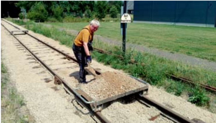
Dort, wo noch Kies fehlt oder zu viel vorhanden ist, schaufelt ihn Joachim Gorr mit Hilfe des Bahnmeisterwagens um. Asendorf, 27. Juni 2020. Foto: RA
