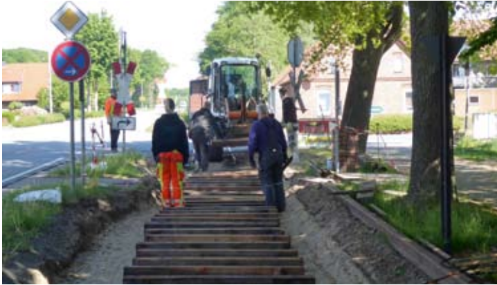
Nahtloser Anschluss an DME 2/20, S. 47: Gleich am 17. Mai 2020 ging es weiter mit der Gleisbaustelle vor Asendorf und dem Auslegen der fehlenden Schwellen per Radlader. Foto: RA
