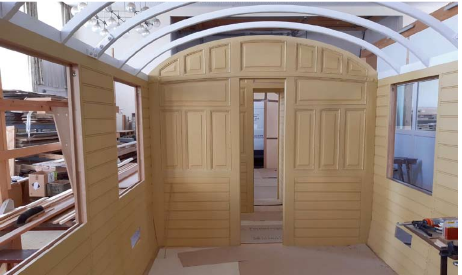
Der Holzaufbau von Wagen Nr. 7 macht in Zwönitz bereits große Fortschritte. Hier das grundierte Innere des 3.-Klasse-Abteils am 29. Juli 2020. Foto: Veikko Hübner
