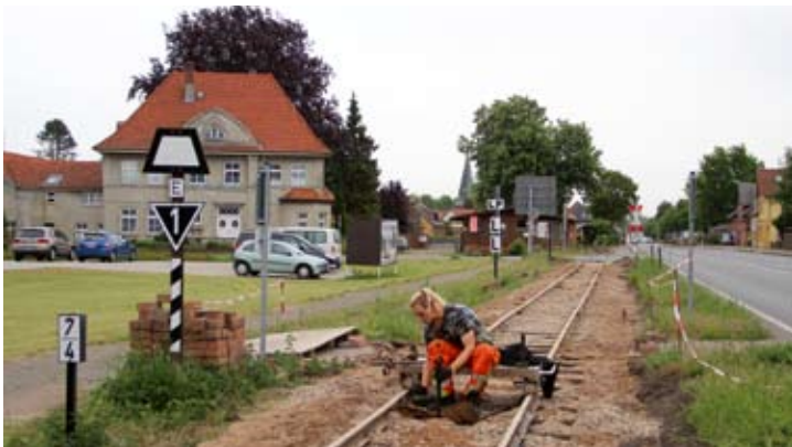
Am 23. Mai ist die Lücke im Gleis vor der Einfahrt in den Bahnhof Asendorf geschlossen, der Kies schon eingebracht, und Max Hunold befestigt die Schienenstöße. 23. Mai 2020, Foto: RM
