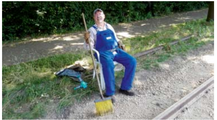
DEV-Urgestein Gerd Schrammen kümmert sich mit dem Besen um den „Feinschliff“ der neuen Kiesbettung. Hier gönnt er sich mal eine kleine Verschnaufpause. Asendorf, 27. Juni 2020. Foto: RA
