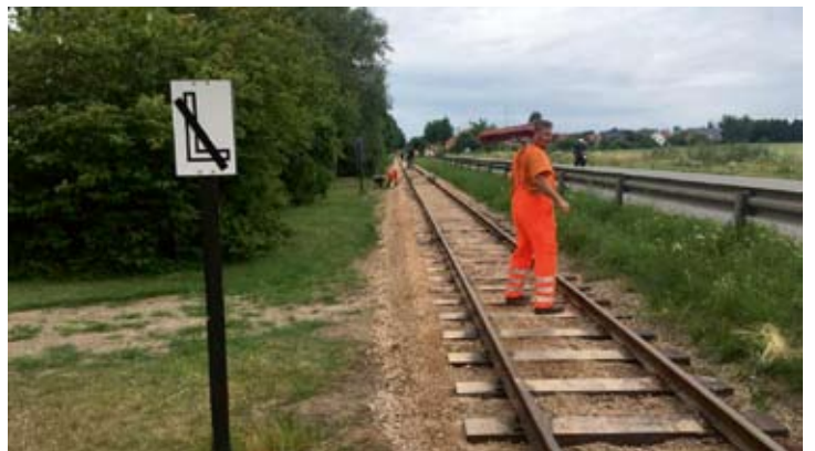
Auch der andere Gleisbauabschnitt am Orteingang ist jetzt fertig gefüllt und gestopft. Guido Tschigor bei den letzten Sauberkeitsarbeiten. 28. Juni 2020. Foto: RA
