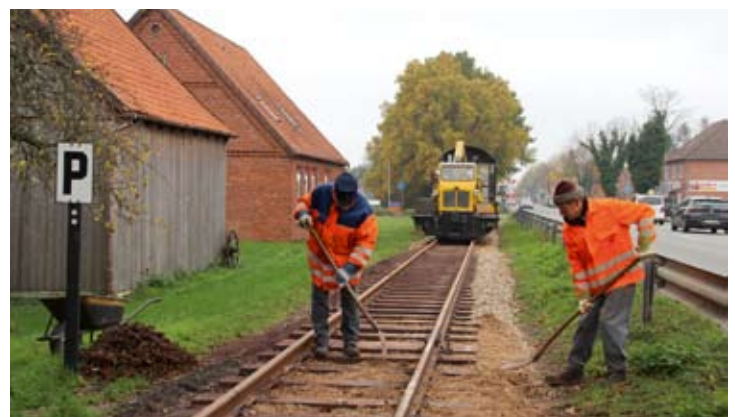
Nach dem Verfüllen und Stopfen konnten Jürgen Werder und Bernhard Öhler die neue Kiesbettung in Asendorf eibebnen. 9. November 2019, Foto: RM
