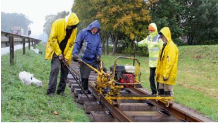
Auch bei mäßigem Wetter musste gearbeitet werden: Mit dem Robel wurden die Schienen festgeschraubt. Asendorf, 12. Oktober 2019.
