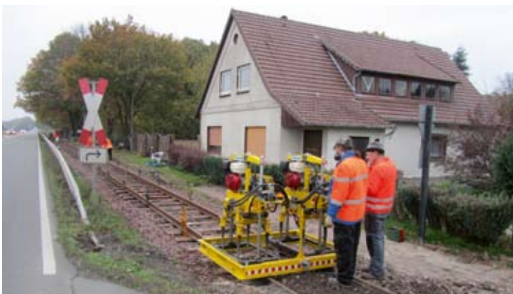
Die Stopfmaschine bewährte sich nach dem Einschottern in Arbste: Jürgen Hunold und Helmut Wilkening freuten sich über das Arbeitsergebnis, 9. November 2019.
