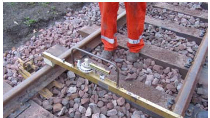
Zwischen den Stopfgängen wurde mit der Wasserwaage nivelliert und ggf. nachgestopft. Arbste, 9. November 2019, Zwei Fotos: Christian Uhle
