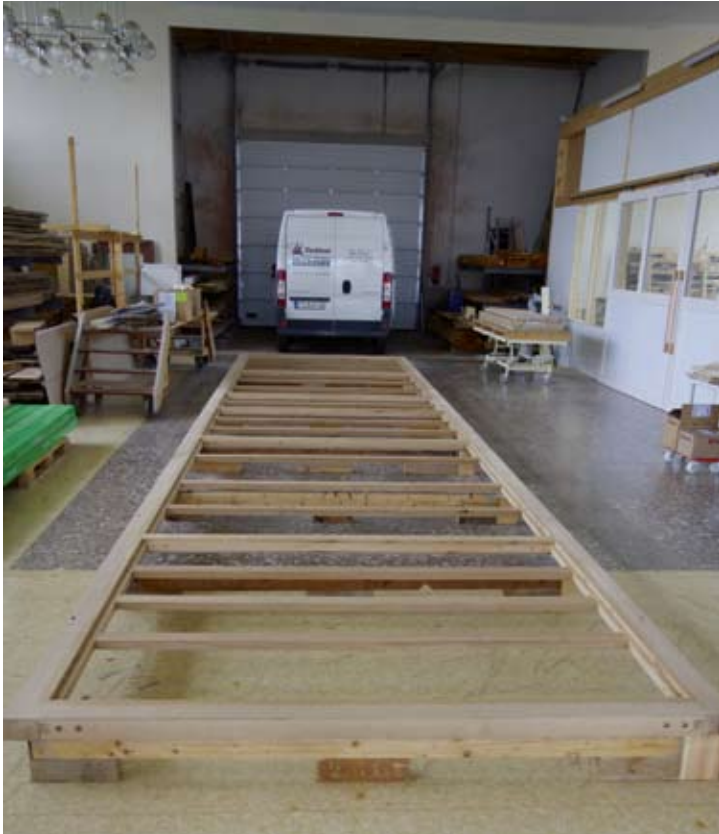
Bei einem Fachbetrieb in Sachsen befindet sich der rekonstruierte hölzerne Wagenkastenbodenrahmen von Wagen Nr. 7 in Arbeit.
