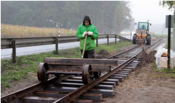
Lars Böcker transportierte die letzten fehlenden Schwellen mit dem Bahnmeisterwagen in der Asendorfer Baustelle.
