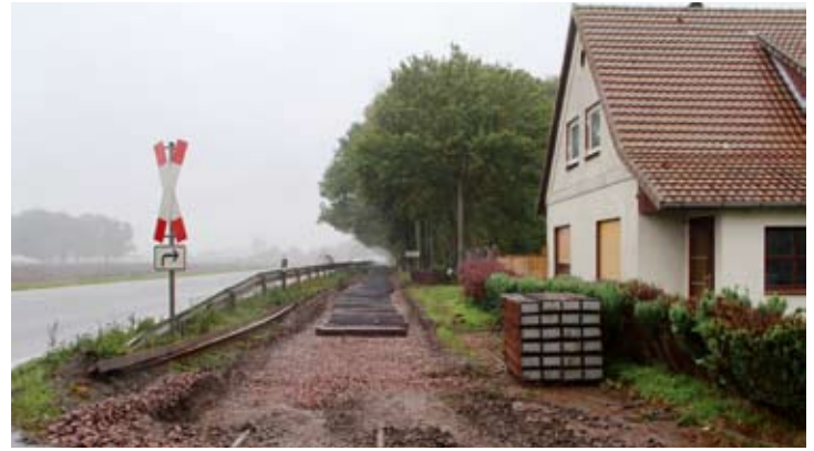
Am Haltepunkt Arbste waren bereits die neuen Schwellen ausgelegt. Das alte Gleis war zuvor zurückgebaut und ein Schotterplanum erstellt worden.
