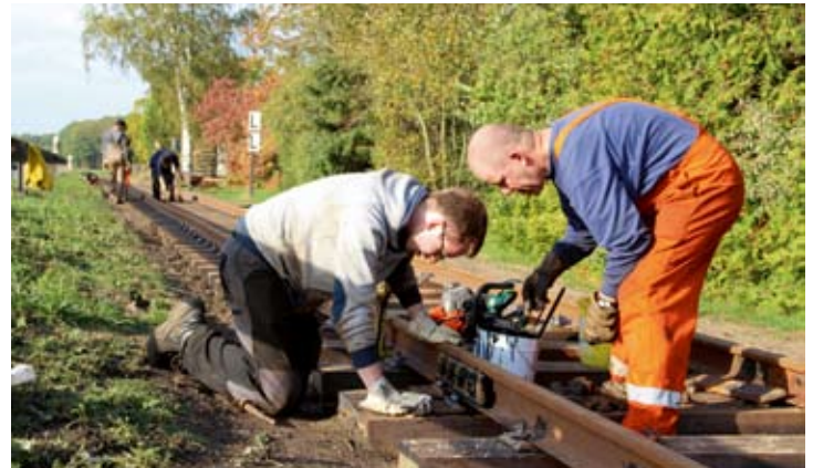
Einen Tag später in Asendorf bei Sonnenschein: Jens Böcker und Jonas Kindermann montierten Schienenstöße und versahen sie mit einem Schutzanstrich. Vier Fotos: RM
