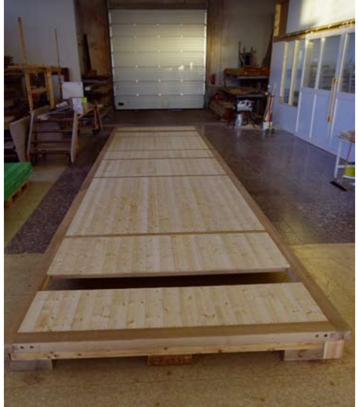
Wenige Tage später war er schon mit Bohlen versehen. Das Bild zeigt die spätere Unterseite. Januar 2020, zwei Fotos: Slg. Uwe Franz
