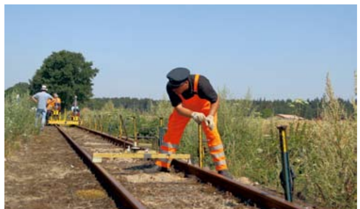
...während Papa und Rotteningenieur Guido Tschigor das Gleis auf die Soll-Höhe brachte. 27. Juli 2019. Zwei Fotos: RM
