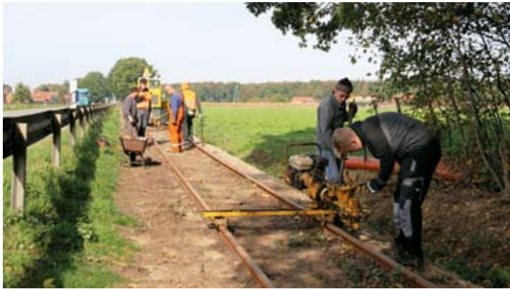
Rückbau des alten Gleisabschnitts in Arbste: Lars Böcker und Bernhard Öhler drehten die Schrauben heraus, während im Hintergrund die weiteren Arbeiten vorbereitet wurden.
