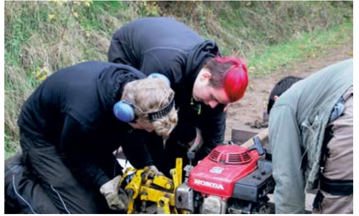
Zum Laschenlöcher-Bohren steckte der Nachwuchs der DEV-Rot- te die Köpfe zusammen (von links): Lars Böcker, Max Hunold und Joshua Broxtermann beim Einrichten der Bohrmaschine.
