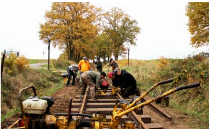
Das Ende der Baustelle in Richtung Vilser Holz einmal in der Tot- talen: Bei bestem Herbstwetter wurde das neue Gleisrost fertiggestellt und an das bestehende Gleis aus dem Einschnitt angeschlossen. 10. November 2018, fünf Fotos: RM
