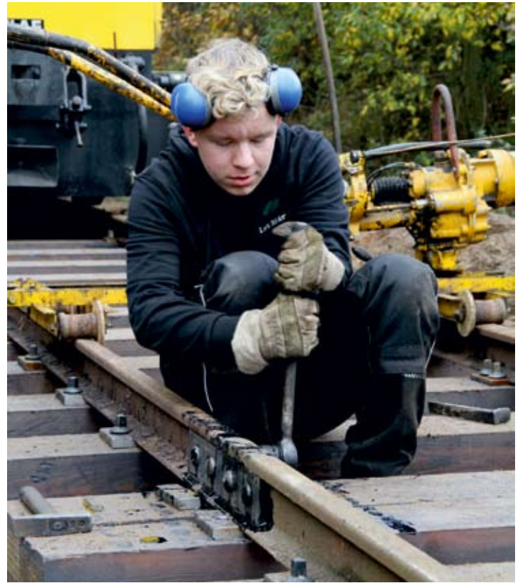
Nach dem Bohren versah Lars Böcker die Schienenlaschen mit Rostschutz und schraubte sie fest.
