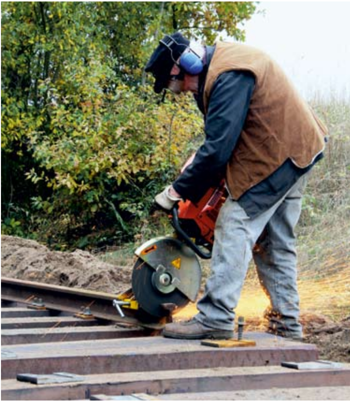
Nach Einweisung am neuen „Schienenmoped“ längte Hartwig Harms die letzten Schienen paßgenau ab.
