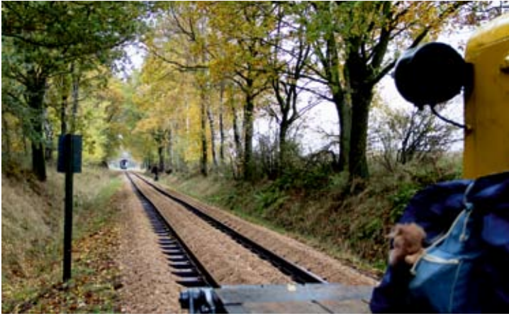
Herbstlicher Gleisbau an der Heiligenberger Kurve am 10. November 2018: Auf dem bereits fertiggestellten Gleisabschnitt wurde bereits die neue Kiesbettung eingebracht.
