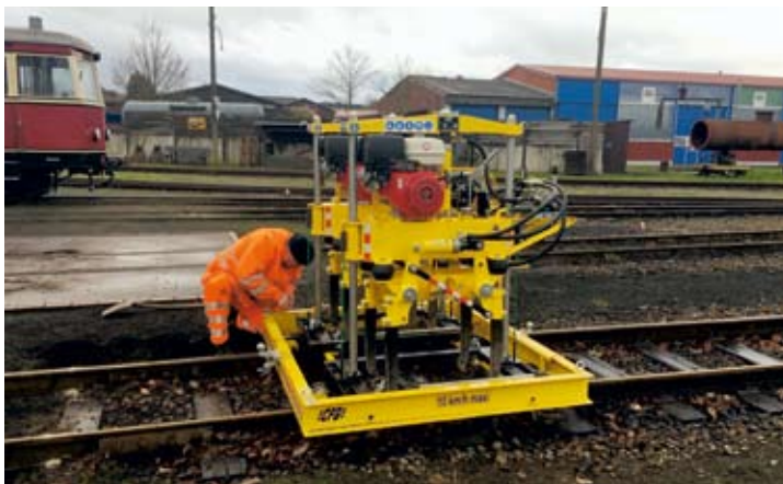
Nachdem die neue Stopfmaschine in mehreren Teilen angeliefert worden war, gingen Guido Tschigor und Jens Böcker sogleich an die Montage. Hier Guido Tschigor mit der schon fast kompletten Maschine am Bahnhof Bruchhausen-Vilsen. Die Maschine wird den Gleisunterhalt in Zukunft wesentlich erleichtern, vielen Dank an die Spender! 8. Dezember 2018, Foto: Jens Böcker
