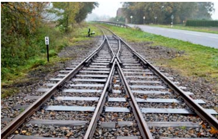
Weiche 3 am Bahnhof Heiligenberg hat nun Kunststoffschwellen – Holzoptik und lange Liegedauer inklusive!
