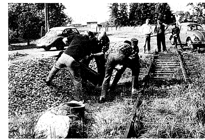
Gleisbau in Heiligenberg, Foto: Weinandt
