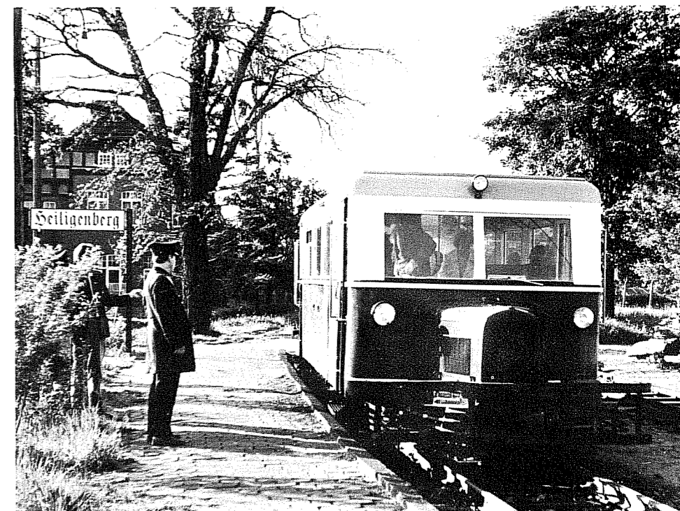
Der T 41 bei einer Probefahrt. Fotos (3): Hentzschel
